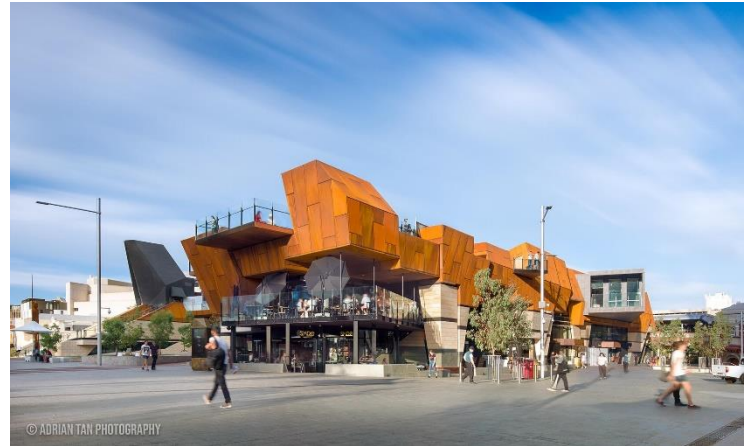
Gambar 6.4 Corten Steel Di Bangunan
