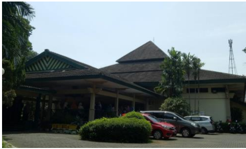
Gambar 4.9 Gedung Pertemuan TBRS Sumber : dokumen pribadi,2019
