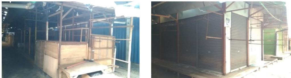
Gambar 4.15 Kondisi Los Komoditas Bahan Kering (Kain dan Perkakas) Sumber: (Dokumentasi penulis)
