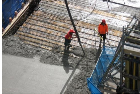
Gambar 4.26 In-Situ Concrete untuk Floor Slabs
