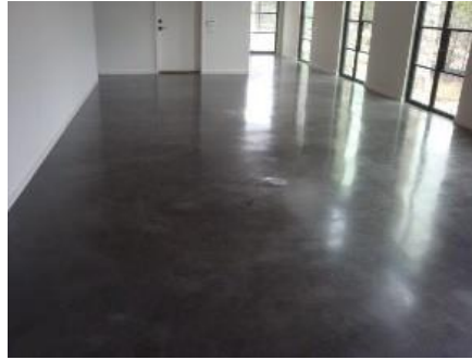
Gambar 4.33 Finished Concrete Floor untuk Flooring
