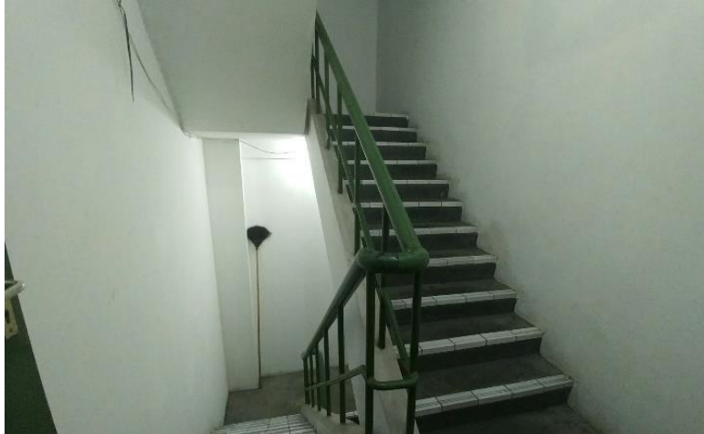
Gambar Tangga Darurat Sumber: Hasil Dokumentasi Survey
