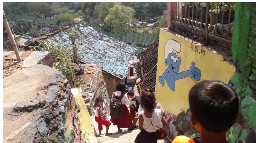
Gambar 3.1 Keadaan jalan yang tidak dapat dilewati kendaraan.
