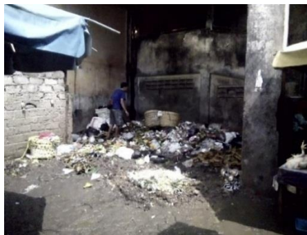
Gambar 3.9 Tumpukan Sampah di Bawah Ramp Pasar Klaten III Lantai (Sumber : Dokumentasi Pribadi, Maret 2019)
