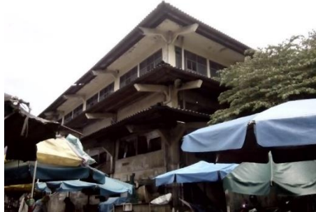
Gambar 3.2 Bangunan Utama Pasar Klaten III Lantai (Sumber : Dokumentasi Pribadi, Maret 2019)
