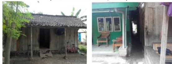
Gambar 4. Jenis Bangunan Non-Permanen (Kiri), dan Jarak Antar Bangunan < 1,5 meter (Kanan), (Hasil Survei Primer, 2014)
