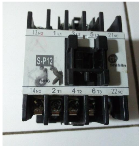
Gambar 2.14 Kontaktor Magnetik Tiga Fasa
