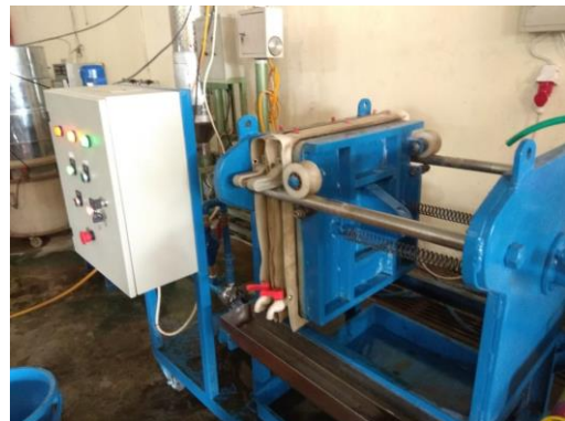
Gambar 9. Proses Filtrasi dengan alat Filter Press Plate and Frame
