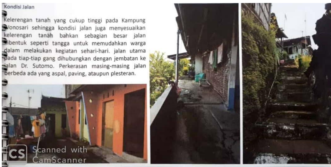
Gambar 2.4 Kondisi Jalan sebelum dibenahi menjadi Kampung Pelangi
