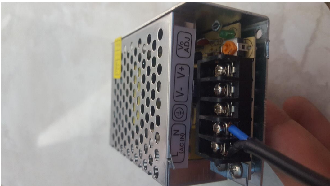
Gambar 4.7 Pemasangan Kabel Input
