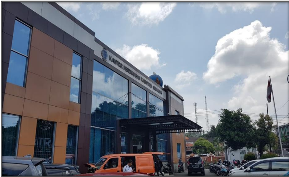
Kondisi Tampak Depan Gedung Kantor Pertanahan Kab. Semarang
