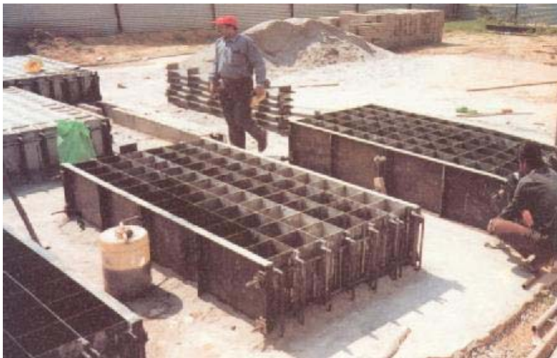
Gambar 6. Produksi beton ringan di lapangan, dengan special desain molds untuk density 1.000 kg/m 3 , di India 35
