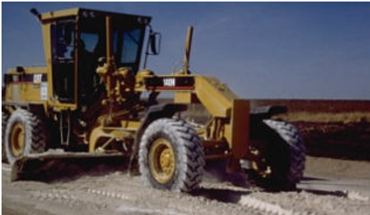
Gambar 11. Pelaksanaan stabilisasi tanah dengan fly ash untuk jalan. 30
