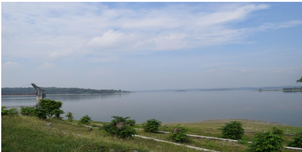
Gambar 2. Waduk Kedungombo Sumber: dokumentasi peneliti (2018)
