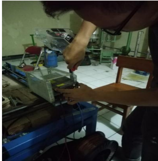
Gambar 3.14 Pemasangan power supply dan saklar pada panel kontrol
