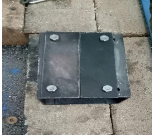
Gambar 3.16 Pemasangan Plat Pada Dudukan Plat
