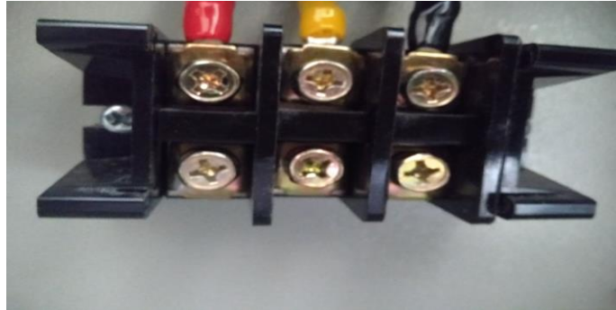
Gambar 2.11 Terminal block (Gambar ini diambil pada tanggal 8 Agustus 2018)
