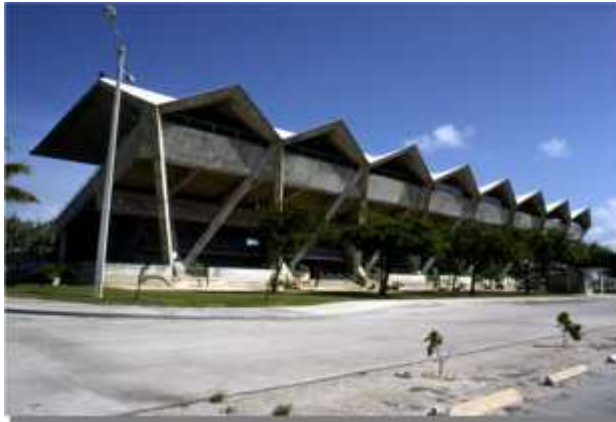
Gambar 17 : Struktur Folded Plate pada Marine Stadium Amerika
