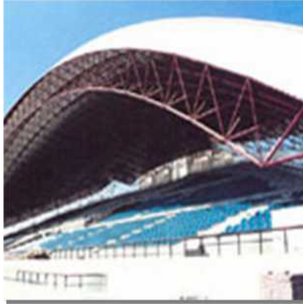
Gambar 14 : Struktur Space Frame GRAND STAND DUBAI (E.A.U.)
