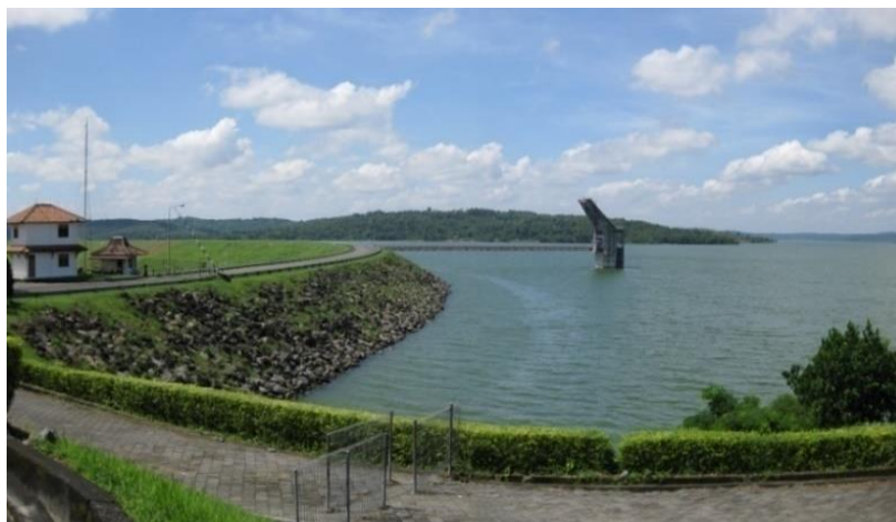
Gambar II- 1 Waduk Kedung Ombo (BBWS Pemali Juana, 2012)
