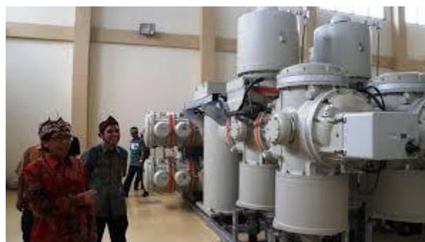
Gambar 2.4 Gardu Induk Berisolasi SF_6 [8]
