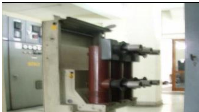
Gambar 2.7 Bentuk Fisik PMT pada Kubikel 20 kV
