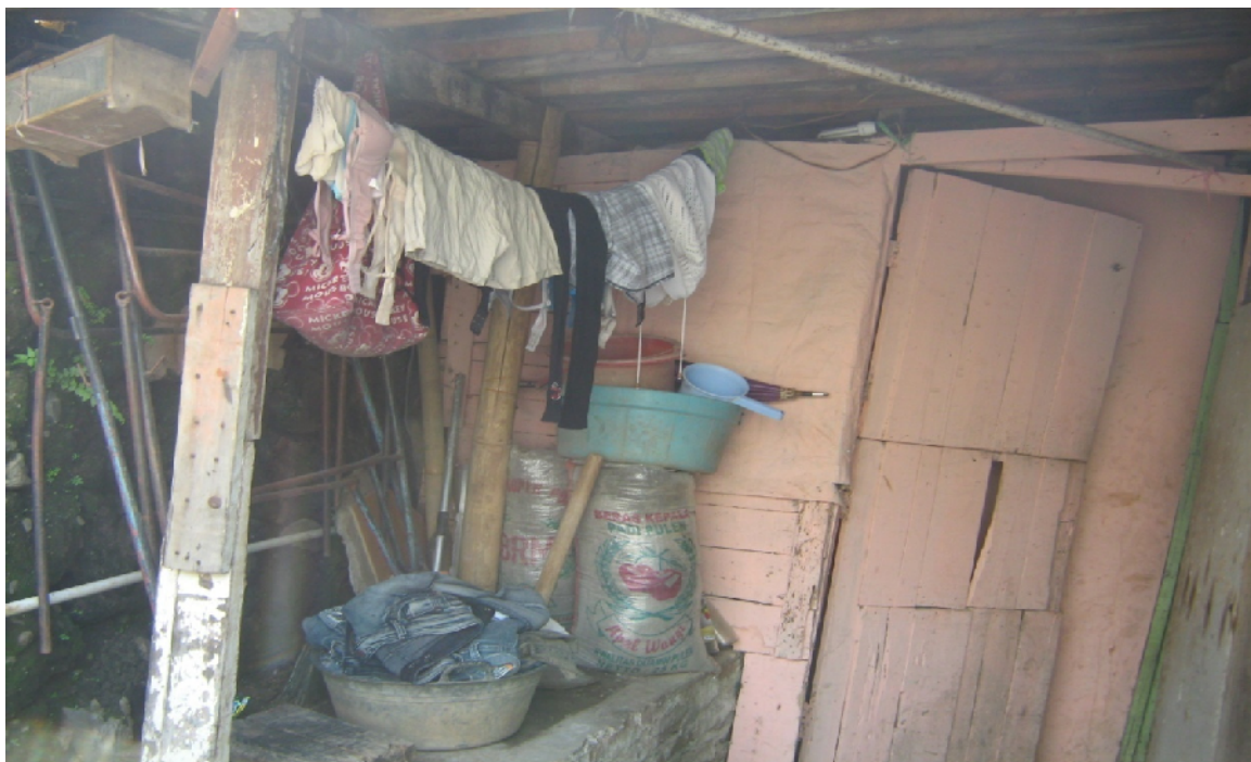
Kondisi kamar mandi yang berada di balik pintu, tidak terdapat bak mandi hanya sebuah ember hitam sebagai pengganti bak mandi, 8 Juni 2010
