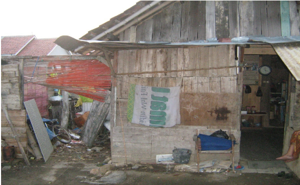
Kondisi rumah orang miskin (tampak depan) di kecamatan Semarang Timur, dengan keadaan yang memprihatinkan dan sangat berantakan. 15 Mei 2010
