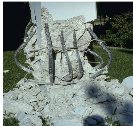
a) Spalling pada Kolom (Kodur, 1999) b) Keruntuhan dan Tekuk Lokal ( Local Buckling ) pada Tulangan Longitudinal Kolom ( EqIIS Collection , 1996)
