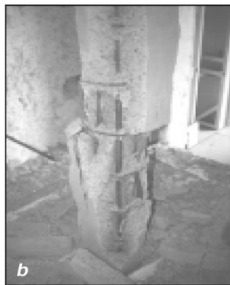
a) Spalling pada Kolom (Kodur, 1999) b) Keruntuhan dan Tekuk Lokal ( Local Buckling ) pada Tulangan Longitudinal Kolom ( EqIIS Collection , 1996)
