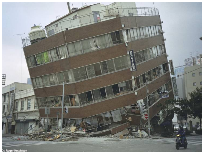
Gambar 1.2. Gedung Runtuh Akibat Kegagalan Kolom Dasar Saat Gempa (Wicaksana, 2010)
