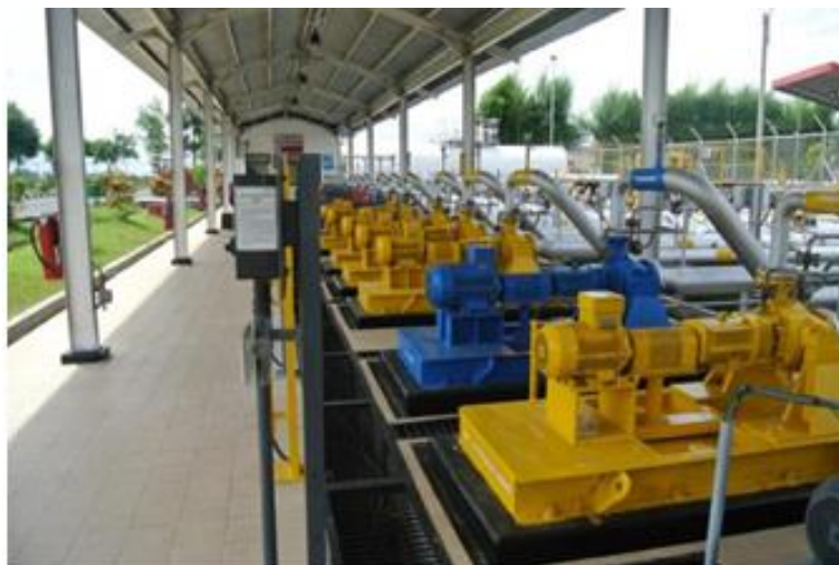
Gambar 2.5 Sarfas Penyaluran ( Pompa Produk )
