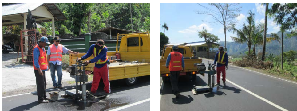
Gambar 3.7. Pengambilan Sampel Uji Campuran Aspal Dengan Core Drill Test
