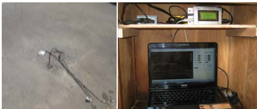
Gambar 3.9. Pemasangan Thermocouple + Data Logger di Lapangan
