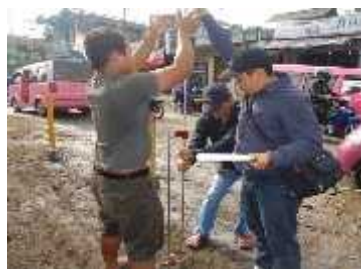
Gambar 3-10. Instal Alat DCP di Lokasi Cianjur-Sukabumi
