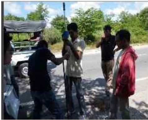
Gambar 3-14. Pelaksanaan Uji DCP di Lokasi Jalan Nasional Kupang-Soe
