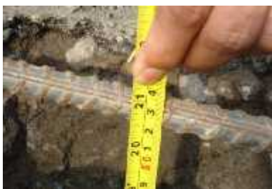
Gambar 3- 9. Pengukuran Ketebalan Perkerasan Jalan
