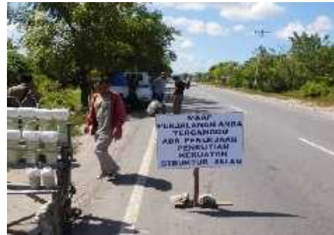
Gambar 3.13. Persiapan Lapangan Uji DCP di Lokasi Kupang-Soe
