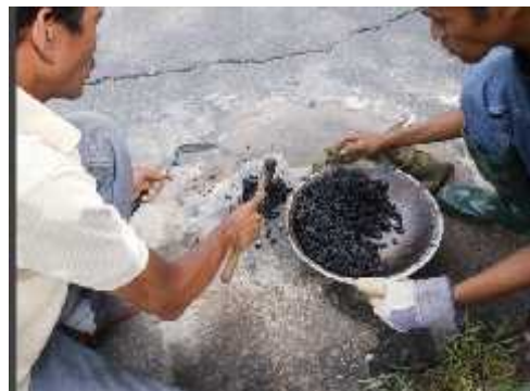
Gambar 3-16. Penutupan Lobang pada Permukaan Jalan Setelah Dilakukan Core Drill
