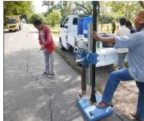
Gambar 3-15. Pembukaan Permukaan Aspal (HMA) Menggunakan Alat Core Drill
