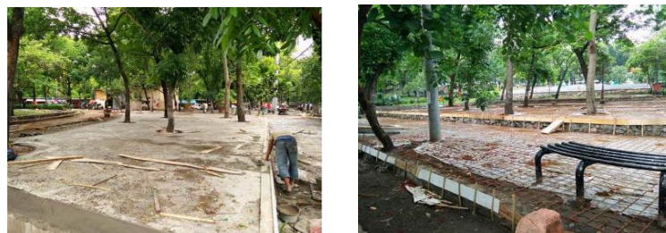
Gambar 4.36 Pengecoran Arena Skatepark
