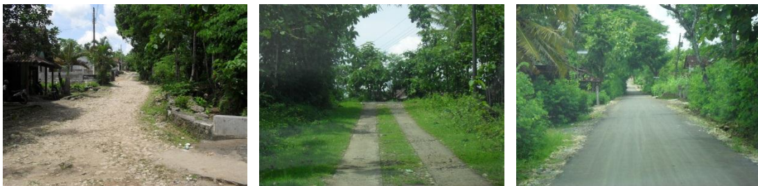
GAMBAR 4.31 Kondisi jalan di Dusun Bulu (Sumber : dokumentasi pribadi )
