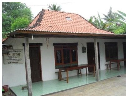
GAMBAR 4.26 Tampak depan rumah Bu Waginem (Sumber : dokumentasi pribadi)
