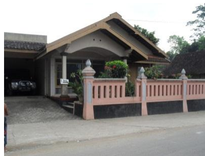
GAMBAR 4.24 Tampak depan rumah Pak Tambiyo (Sumber : dokumentasi pribadi)
