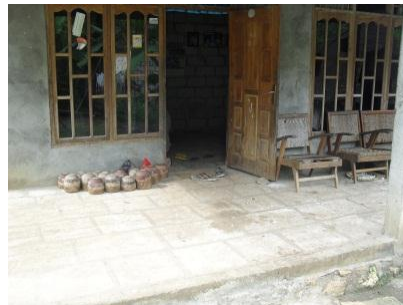
GAMBAR 4.47 Kondisi teras rumah (Sumber : dokumentasi pribadi)
