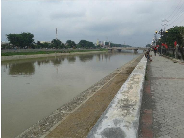
**Gambar IV.14. Talud beton mengurangi sedimentasi Sungai Banjir Kanal Barat**
