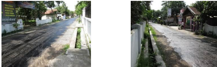
Gambar 4.28 : Perbaikan Jalan-Jalan Sekunder Sumber : Survey Lapangan, 2013
