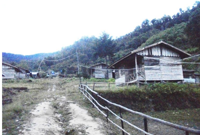
GAMBAR 4.5. RUMAH PAPAN BANTUAN DINAS SOSIAL YANG DIBANGUN MENGHADAP JALAN UTAMA DI KAMPUNG DEMAISI
