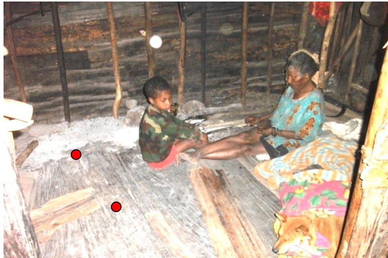
GAMBAR 5.1. TITIK UKUR SUHU PERMUKAAN LANTAI RUANG TIDUR IBEIYA SENG
