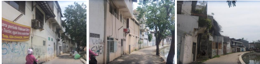
Gambar 5.9 Fasad Bangunan yang Membelakangi Kali Semarang Sumber : dokumentasi pribadi, 2014
