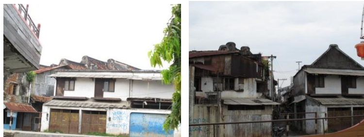
Gambar 5.9 Fasad Bangunan yang Menghadap Kali Semarang Sumber : dokumentasi pribadi, 2014
