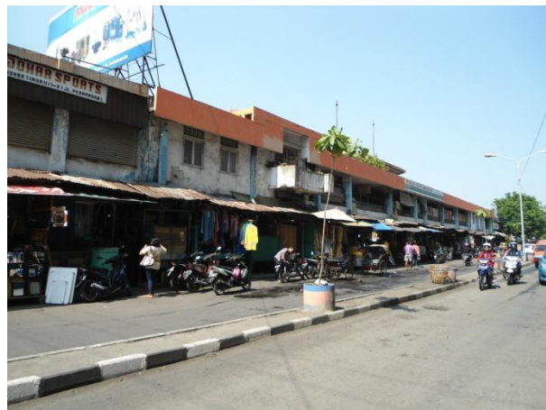
GAMBAR 4.20 BANGUNAN PASAR JOHAR YANG TERTUTUP OLEH ACTIVITY SUPPORT
