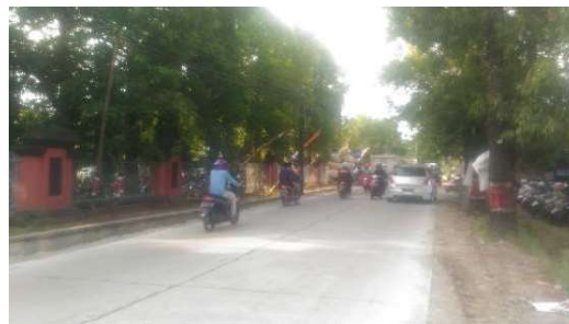
Gambar 66 Akses jalan utama menuju lokasi tapak SD Semesta Kudus
