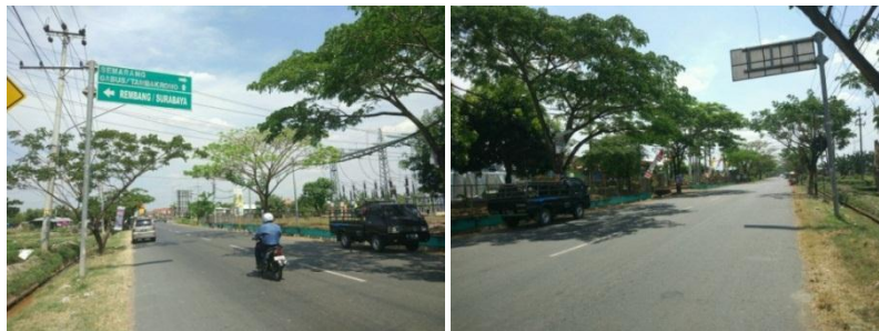
Gambar 5.4 Kondisi Jalan Raya Pati-Gabus
