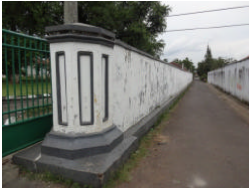
Gambar 4.1 Pagar tembok Benteng Sumber : Survey lapangan,2014
