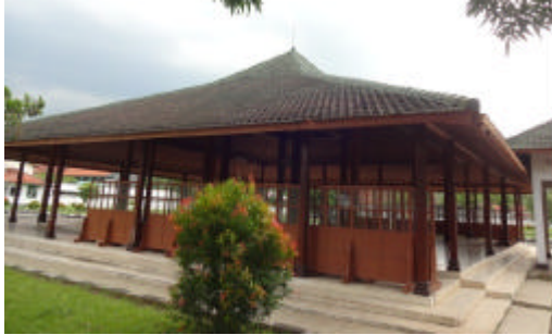
Gambar 2.18 Tampak timur duplikat Pendapa Si Panji di Banyumas tanpa Kuncungan. Sumber : Survey lapangan 2014
