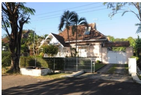
Gambar 4.9 : Salah satu rumah mengalami penambahan bagian teras dengan menggunakan atap pelana yang disesuaikan dengan kebutuhan penghuninya serta tambahan bagian samping berupa pintu untuk garasi dan kondisinya sangat terawat berada di jl. Solo, sumber : dokumentasi pribadi, 2011.
