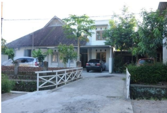
Gambar 4.16 : Salah satu rumah mengalami penambahan bangunan baru disampingnya sebagai kamar kos yang desainnya sangat kontras dengan bangunan aslinya dengan gaya atap datar dan tambahan kanopi didepannya berada di jl. Gundih, sumber : dokumentasi pribadi, 2011.
