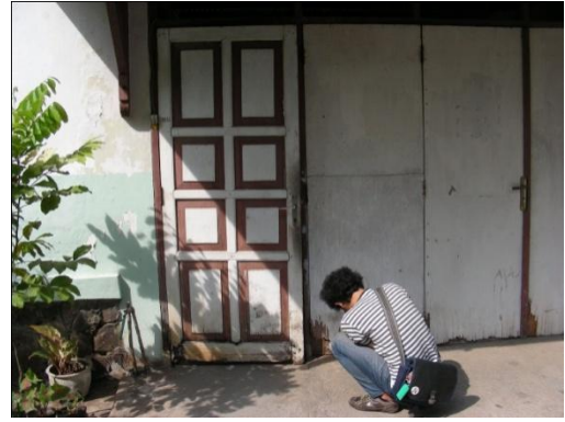
Gambar 4.51: pintu garasi rumah jl. Kedungdjati no. 8, sumber : dokumentasi peneliti, 2012.
