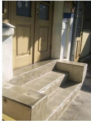
Gambar 4.26 : Tangga kecil pada pintu masuk rumah utama di Perumahan Woningpark Gergadji. sumber : dokumentasi peneliti, 2012.
