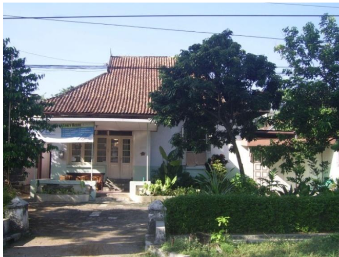
Gambar 4.49: Fasad rumah Jl. Kedungdjati no. 8. sumber : dokumentasi peneliti, 2011.
