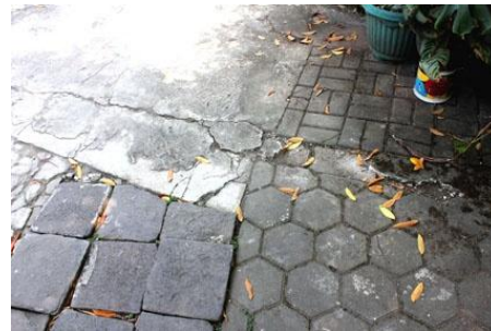
Gambar 4.47: Susunan batu dan paving pada halaman rumah Jl. Jogja no.20, sumber : dokumentasi peneliti, 2012.
