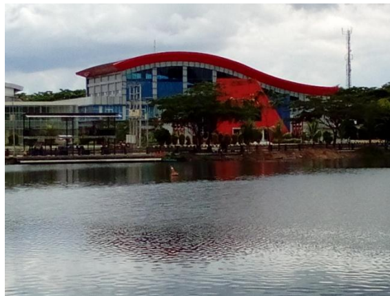
Gambar 4.2. View Bangunan Gedung anggar dari seberang polder
