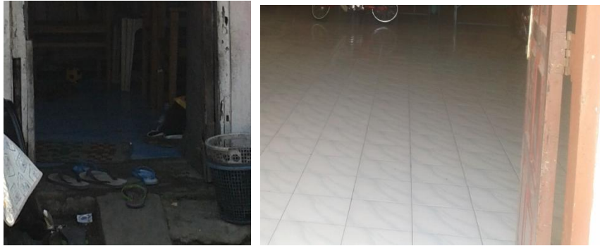
Gambar 5.3.13 Lantai Bangunan Sumber : Dokumentasi Pribadi 2015
