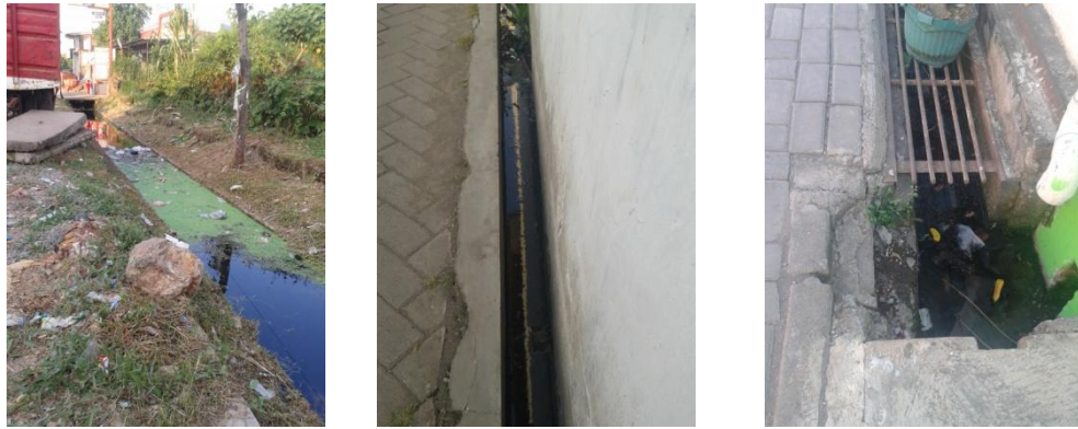
Gambar 5.5.8 Kondisi Saluran Sumber : Dokumentasi Pribadi 2015
