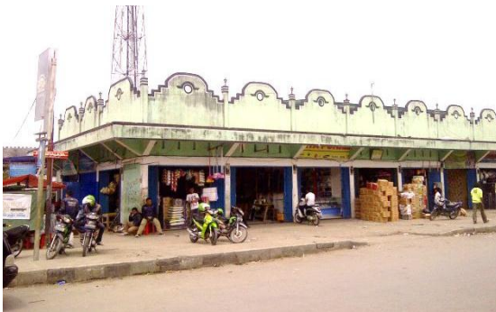
Gambar 3.3. Bangunan Ruko Berlantai Satu Sumber: Dokumentasi Pribadi, 2014
