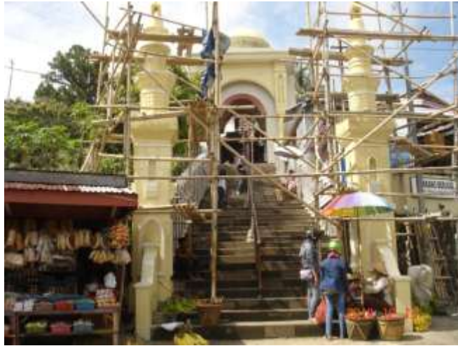
Gambar 5.4 : Pintu Gapura sudah direnovasi /dirubah Sumber : Dokumentasi penulis, 2014
