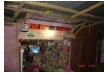
Gambar 4.12 :Kios buku yang terletak ditikungan dengan atap yang sangat sederhana dengan bambu dan atap asbes
