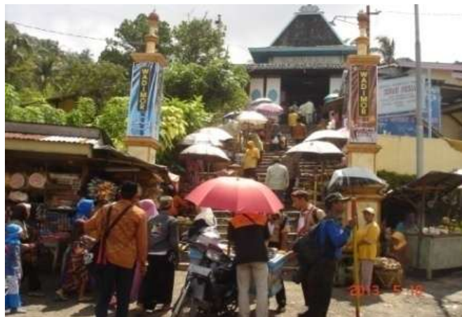
Gambar 5.3 : Pintu Gapura belum direnovasi /dirubah
