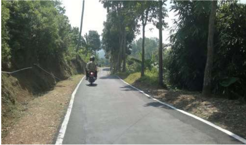
Gambar 5.20 : jalan mendatar sudah di lapisi aspal
