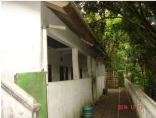
Gambar 5.10 : Foto toilet dengan keadaan yang sederhana direnovasi pada tahun 2005
