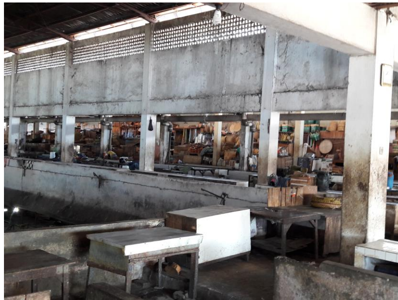
Gambar 4.1 Fasilitas Bangunan Pasar Karangayu (dokumentasi, 3 Agustus 2017)
