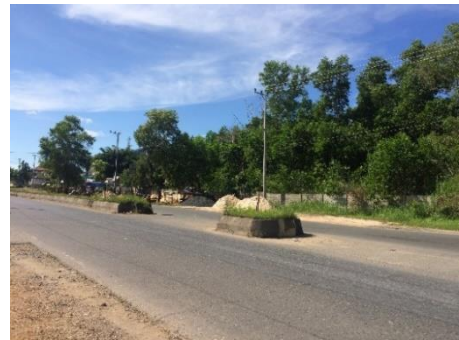
Gambar 5.5. Kondisi jalan depan tapak Sumber: Dokumen pribadi
