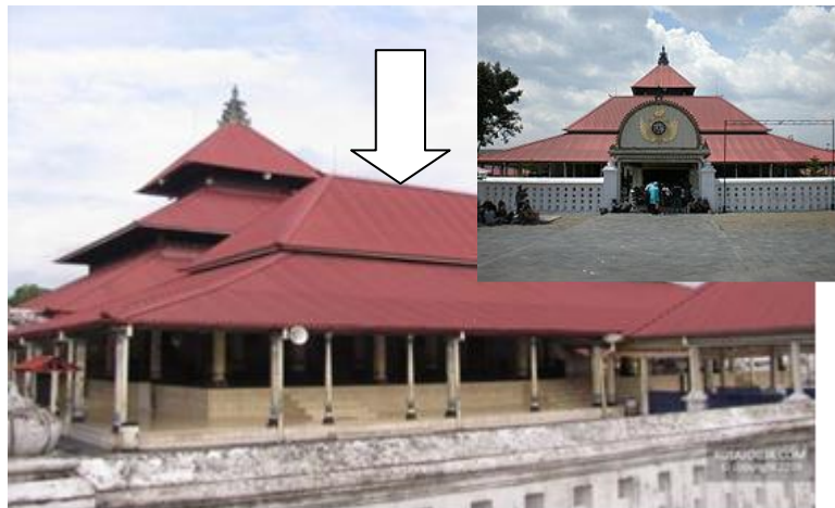
tampak samping bangunan, bentuk bersusun dua
