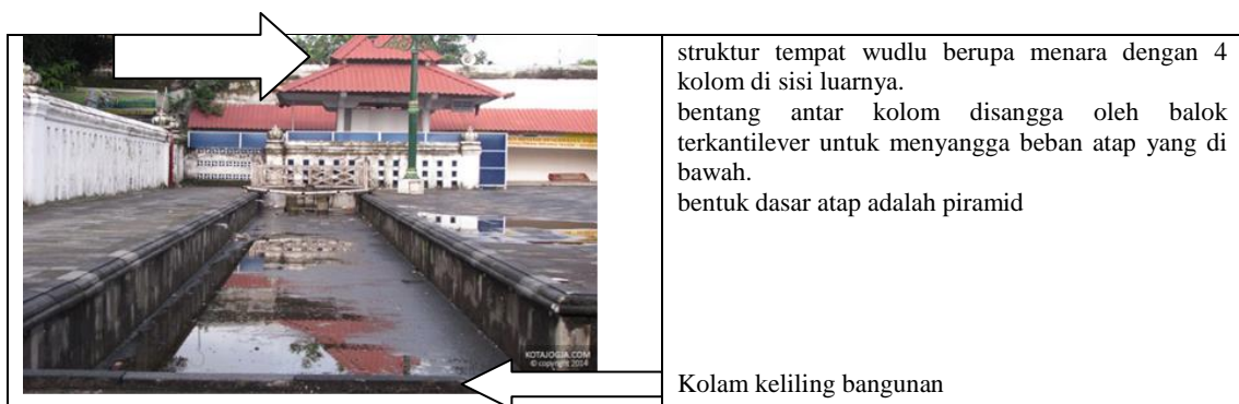
Gambar 10. Bangunan tempat wudlu
