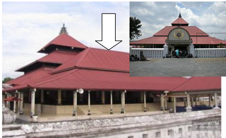
tampak samping bangunan, bentuk bersusun dua
