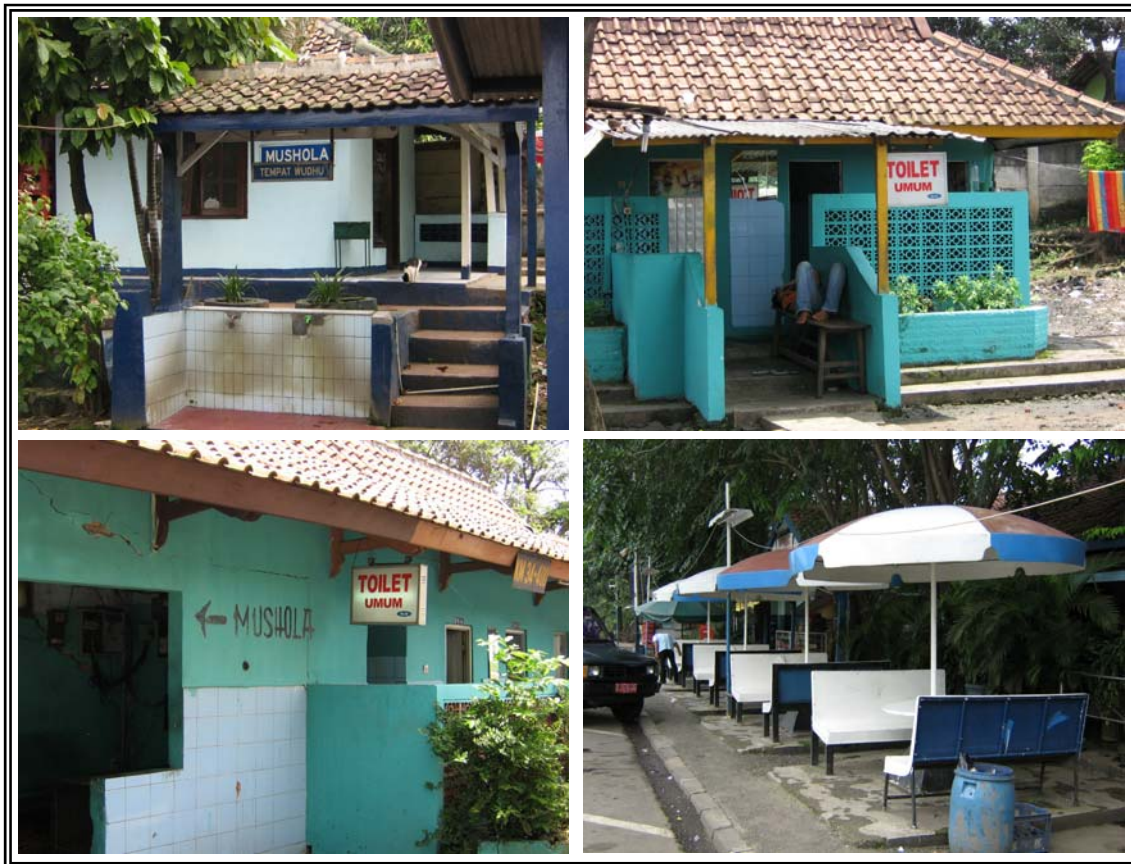
GAMBAR I.1 KONDISI FISIK SARANA PELAYANAN REST AREA PADA BEBERAPA LOKASI REST AREA
