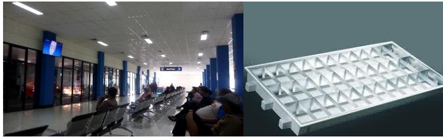
Gambar 6.5. lampu TL dengan Grill Reflector di Terminal Tirtanadi (Sumber: dokumentasi pribadi)
