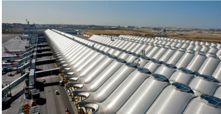
Gambar 5.16 Struktur dan Material atap Bandara Internasional Barajas
