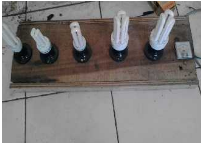
Gambar 3.17 pembuatan instalasi lampu
