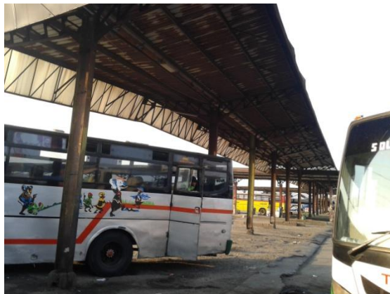
Gambar. 1.5 Struktur bangunan pada terminal Terboyo
